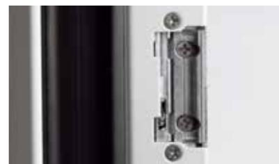
**Brava na vratima TSH** služi kao limitator otvaranja. Njome se upravlja izvana preko glavne brave (bez vanjskog cilindra). Iznutra se aktivira preko okretnog gumba.
